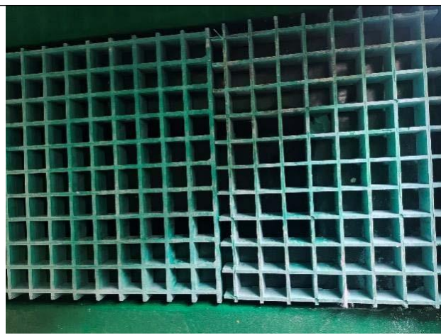
化学品库地沟照片
