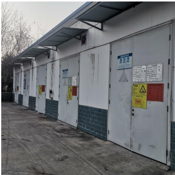
危废暂存间外部现状照片
