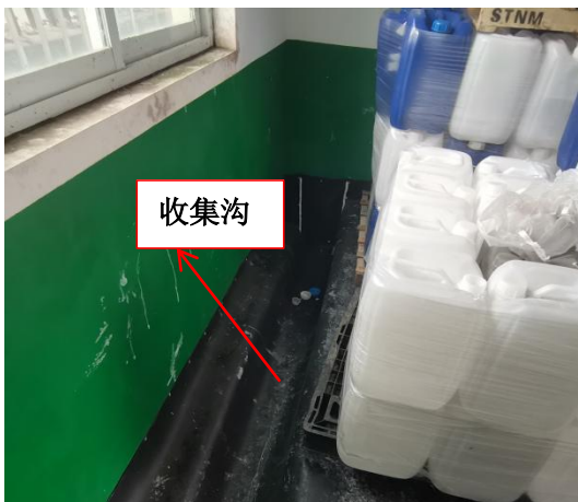
危废暂存间内部现状照片
