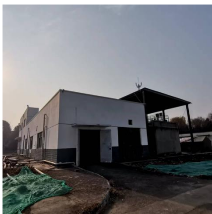
污水处理站现状照片
